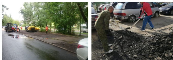
Асфальтирование проезда вдоль дома 88 по ул. Свердлова
